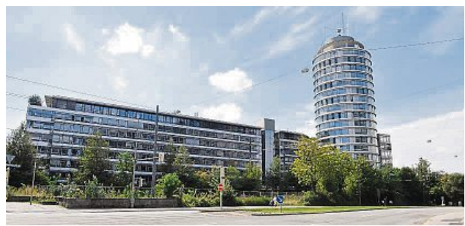
Das Technische Rathaus: Der Hospizdienst „DaSein“ will in seiner Nähe bauen. FOTO: KLAUS HAAG
